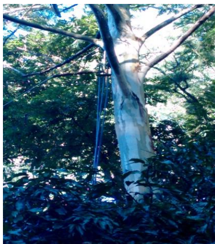
Figura 11: Suporte para suspensão das mangueiras (Fonte: Autoria própria)
