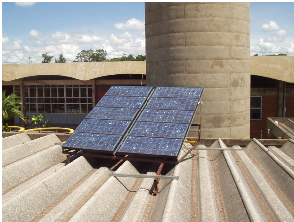
Figura 1: Sistema fotovoltaico isolado.
