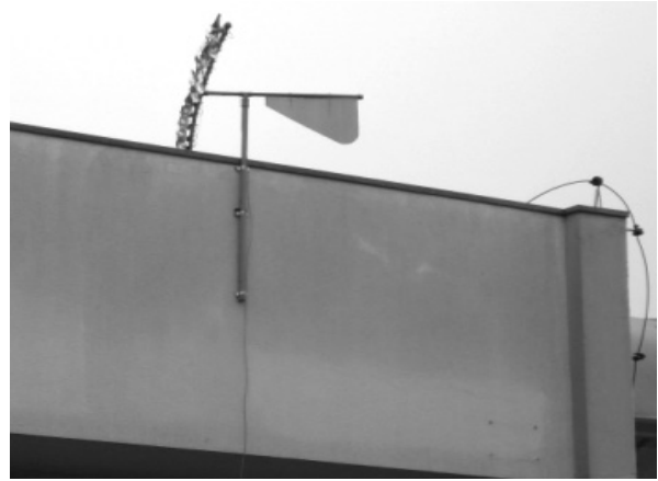
Figura 8 – Aspecto final do protótipo instalado.
