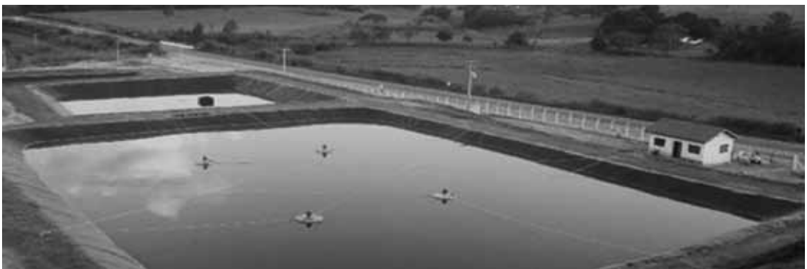
Figura 7: Piscinas de decantação de sólidos da estação de tratamento de sólidos. Tapiratiba/SP. Fonte: PENHA, E.T.S. (2012).
