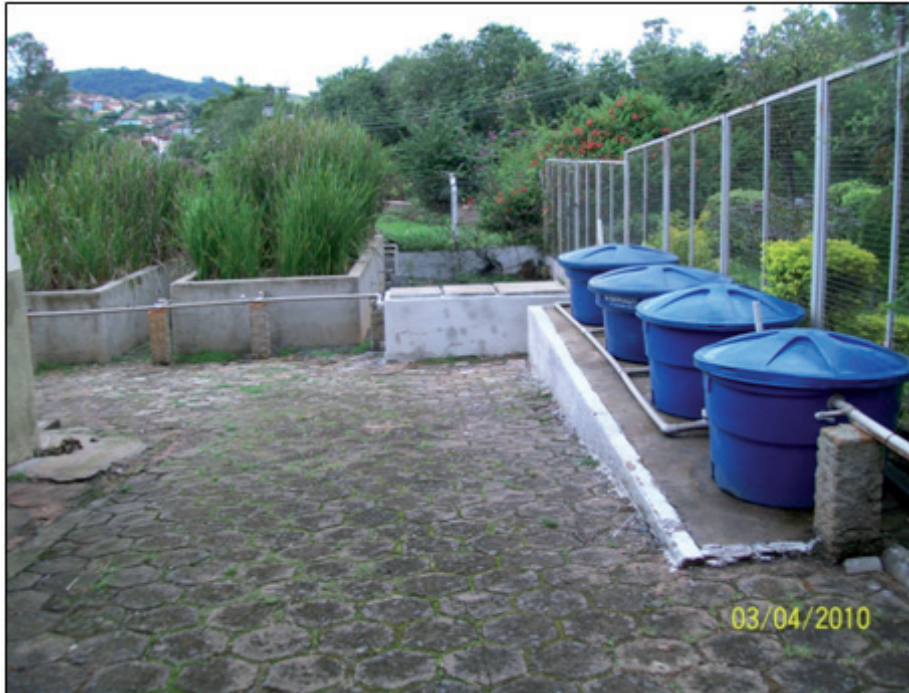
Figura 2: Sistema de Tratamento – vista geral. Fonte: Elaboração dos autores.
