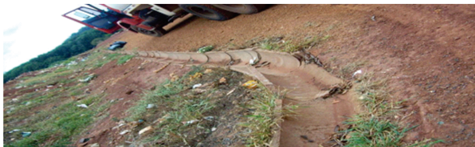
Figura 4: Canaletas que drenam águas pluviais do aterro sanitário.
