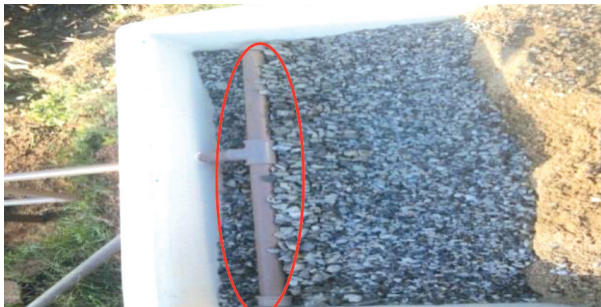
Figura 3a. Tubulação perfurada na superfície para coleta dos resíduos pré-filtrados. Fonte: Elaboração própria.
